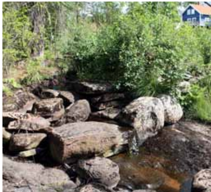
Rest av fördämningsvallen vid A3.
