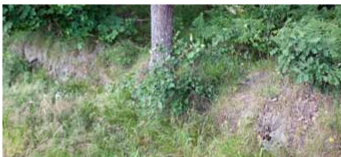
Utmed cykelbanan ligger en låg stenvmur av granitblock.
