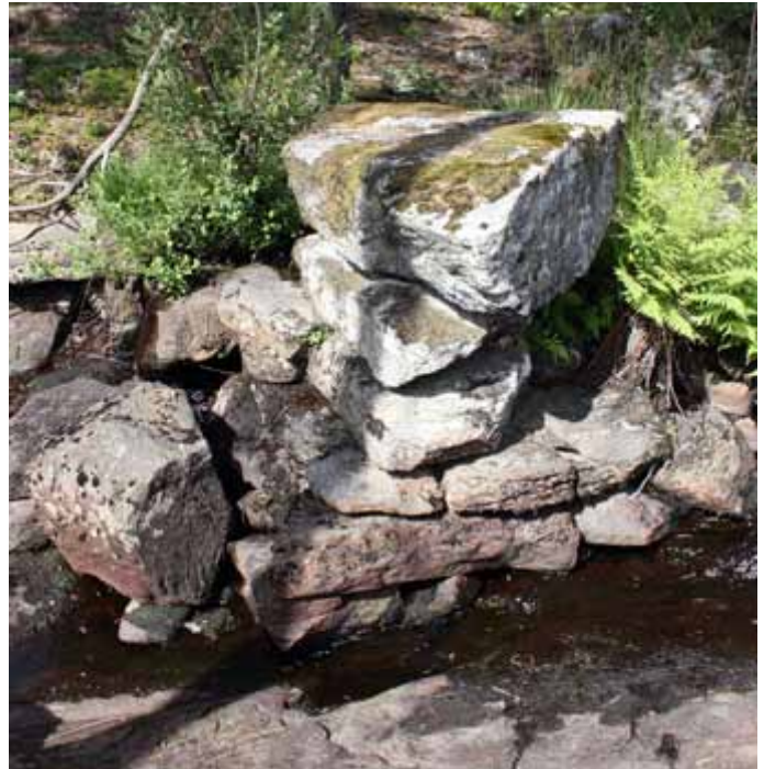
Vid A3 har det legat både kvarn och såg, som hörde till Önneröd. Här syns ett kallmurat fundament efter en av byggnaderna.
