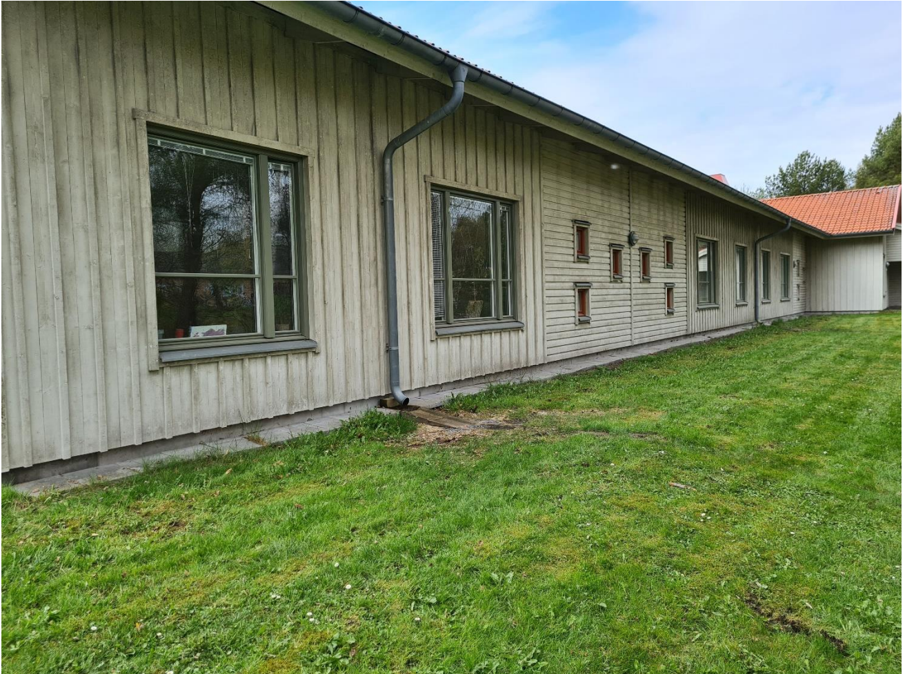
Figur 12. Förskolan Djupedal. Det finns inga extra trappsteg eller annat som tillsammans med naturliga konsolideringssättningar antyder att byggnaden är pålad.
