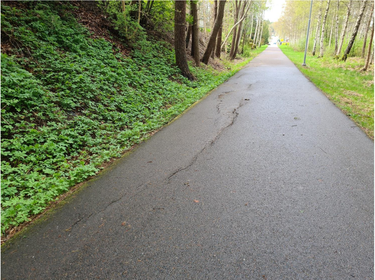
Figur 14. Uppsprucken GC-vägsbeläggning.
