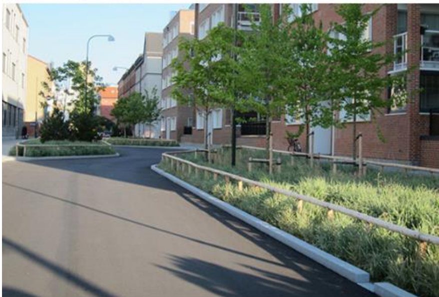
Figur 13. Exempel på regnbäddar intill hårdgjorda ytor. Dagvatten leds till regnbäddarna via kantstensöppning (Bara Mineraler).
