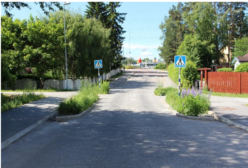
Figur 15. Regnbädd längs en bilväg med kantstensöppning, Örningevägen 2017.
