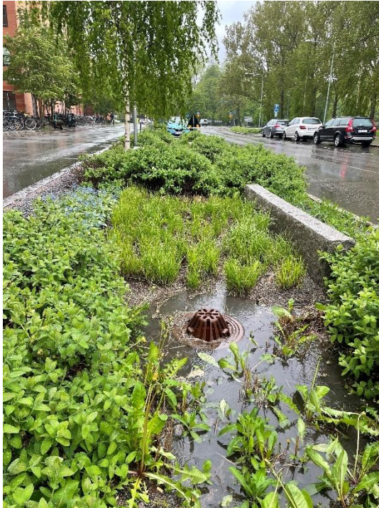
Figur 14. Regnbädd på Stranbodgatan i Uppsala, 2021
