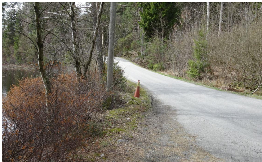
Bild 39 tagen på vägen mot sydväst. Lägsta delen av vägen är vid konen.
