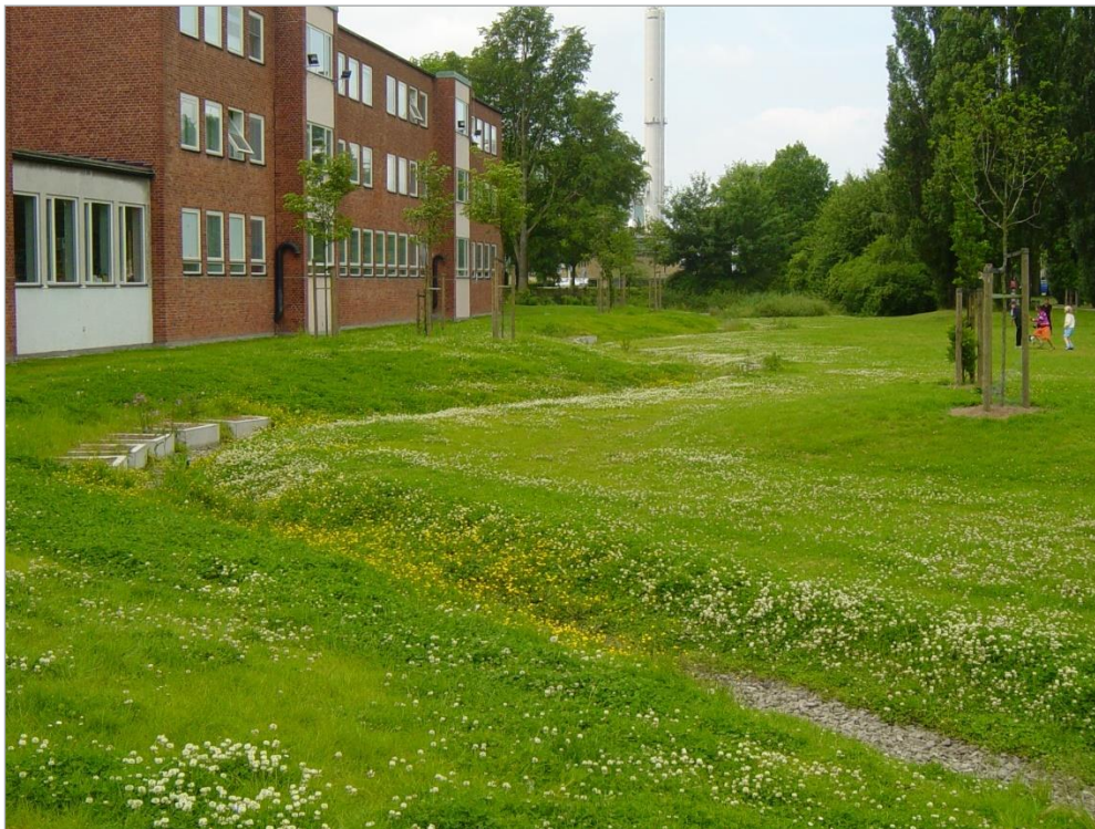
Figur 25. Exempel på utformning av ett svackdike (Foto: Norconsult)
