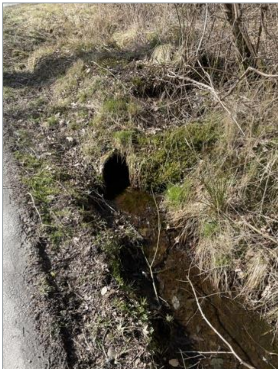
Figur 18. Kulvert och dike väster om Bockövägen (Foto: Norconsult)
