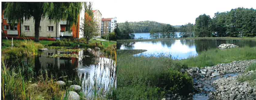
Figur 18. Exempel på dagvattendammar med permanent vattenyta.
