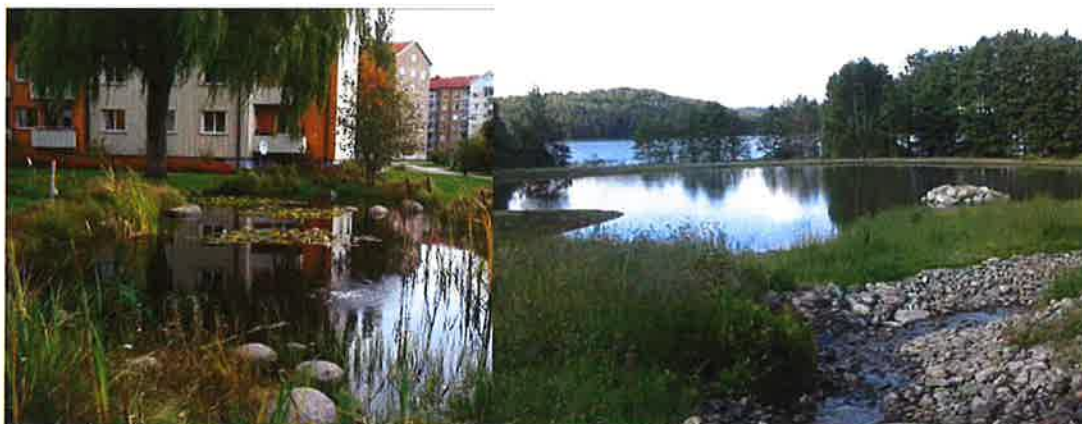
Figur 18. Exempel på dagvattendammar med permanent vattenyta.
