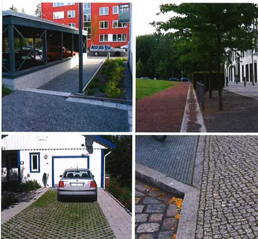
Figur 8. Exempel på genomsläppliga beläggningar.
