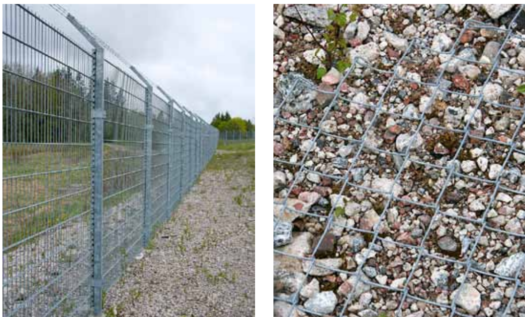
Figur 8. Viltsäkert staket med utvinklad nedre del före övertäckning/nedgrävning. Stockholm Arlanda Airport juni 2009. Foto: P-G Bentz / Sturnus.
