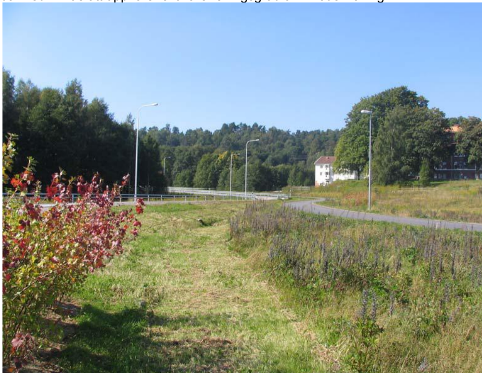
Bild 3. Exempel på ett gräsbeklätt vägdike med flacka slänter.
