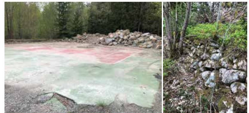
Rester av inomhusbana och fundament för barracudatält. Vid dess cementgrund, mot Fjällstedsvägen, syns rester av stödmur för ursprunglig tennisbana.
