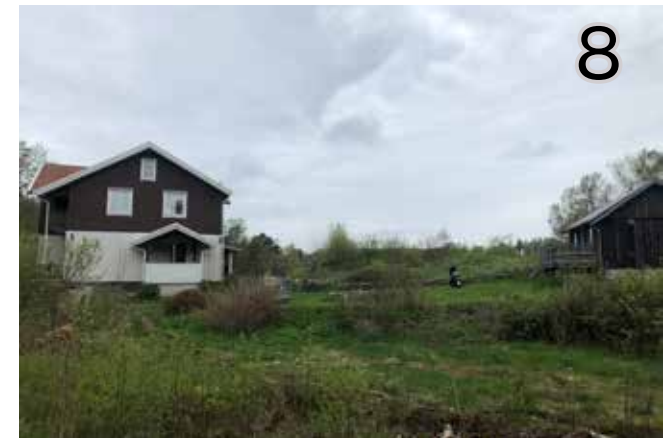
Byggnaden på fastighet 1:261 har en övergripande nationalromantiskt prägel med sockel av huggen sten och loggia åt söder med snidade bärande pelare.
