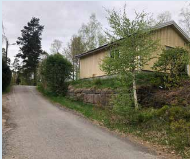
Stödmur i sutterräng med större huggna stenblock inom fastighet 1:222.
