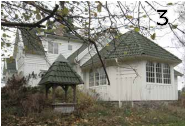
Villa på fastighet 1:77, uppförd 1910-tal. Fasadklädsel med en hyvlad lockpanel och liggande panel på förvandring. Tillbyggd i omgångar bland annat på 1930-talet för konstnärinnans Agnes de Frumerie ateljé.
