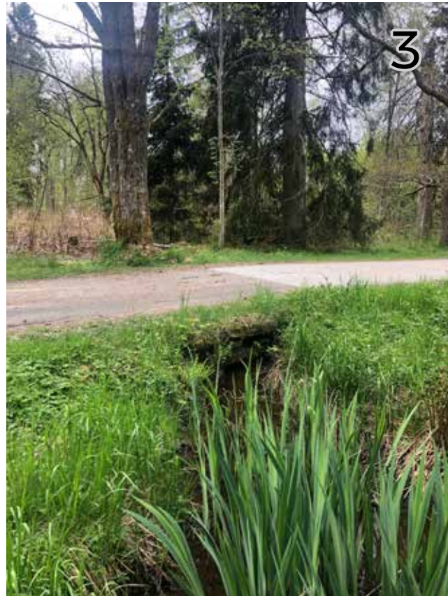
Enklare stensättning för vägpassage (Ringvägen) över bäck.
