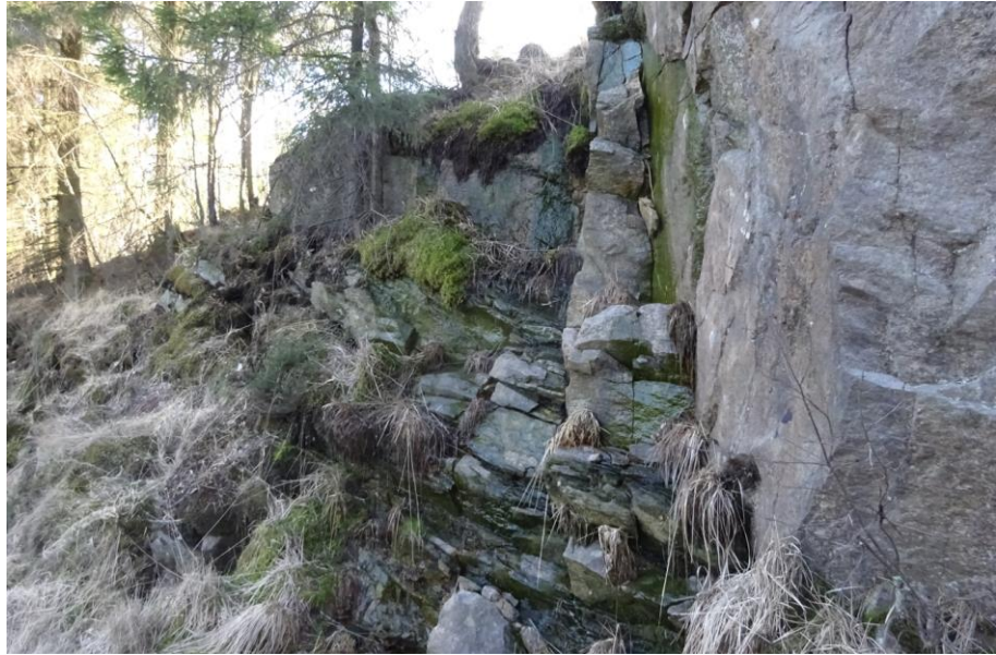
Figur 11 Bergsskärning vid väg 535 där man ser ett lokalt stråk med mer uppsprucket berg där även mindre mängd ytligt vatten påträffades.
