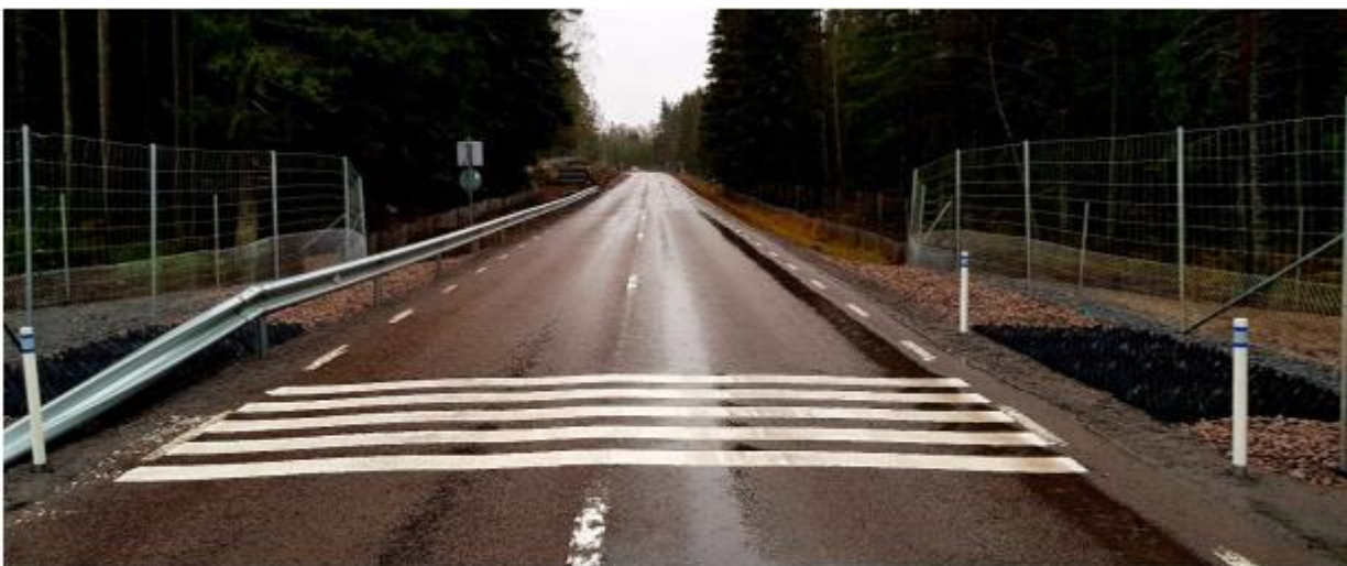
Figur 8. Linjer tvärs över vägbanan i syfte att leda djuren över vägen och även underlätta att fordonsförare ser djuren vid mörker eller dålig sikt. (Bild från Utredning av barriäreffekter för större däggdjur vid exploatering utmed Partillevägen förbi Öjersjö (Enviro planning, Marcus Elfström, 2023)).
