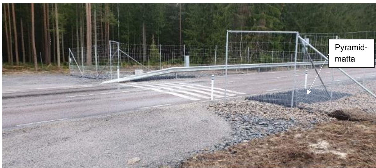
Figur 9. Bild inifrån detektionsyta i faunapassage i plan och ut mot vägbanan och stängslingen. (Bild från Utredning av barriäreffekter för större däggdjur vid exploatering utmed Partillevägen förbi Öjersjö (Enviro planning, Marcus Elfström, 2023)).
