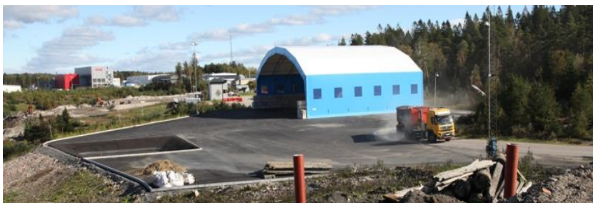
Figur 4-3. Exempel från befintlig verksamhet med yta för mellanlagring av avfall med tält som nederbördsskydd.
