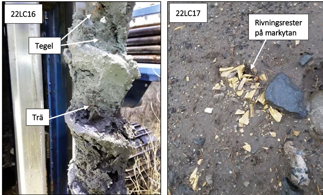
Figur 7. Exempel på massor från området med förekomst av tippmassor, där bilden till vänster är tagen i punkt 22LC16 på 3,5–4,0 meters djup och bilden till höger är tagen på markytan vid punkt 22LC17.
