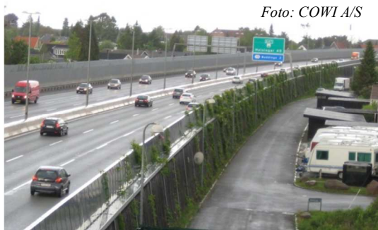
Figur 18 Exempel på bullerskyddsskärm längs motorvägen M3 runt Köpenhamn.
