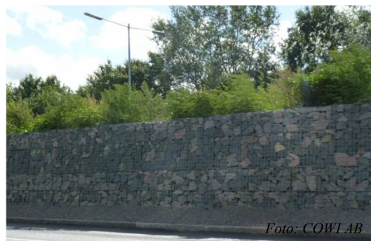
Figur 25 Bullerskyddsvallen till vänster sett från lokalvägen. Exempel hämtat från Frölunda torg, Göteborg.
