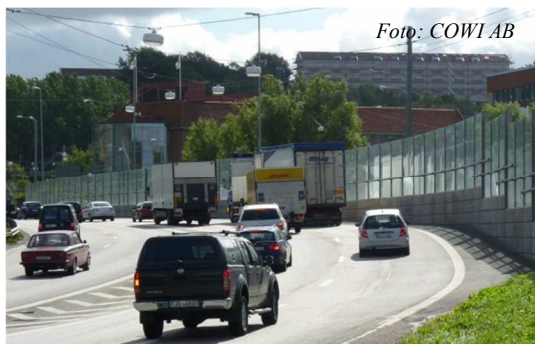
Figur 14 Exempel på bullerskyddsskärm i betong och glas från Gårda, Göteborg.
