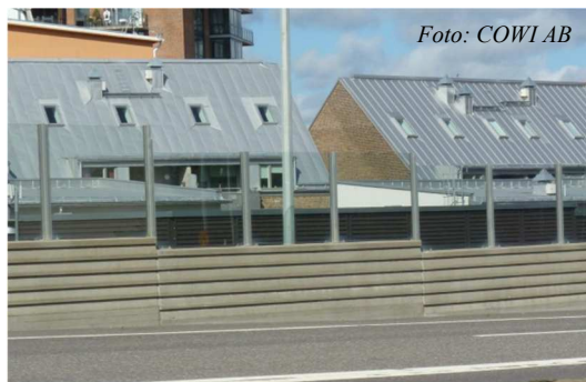
Figur 15 Exempel på bullerskyddsskärm i betong och glas från Klippan, Göteborg.
