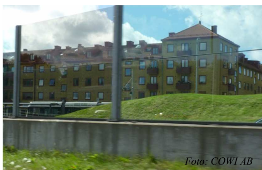
Figur 16 Exempel på bullerskyddsskärm i betong och glas från Mölndals centrum, Mölndal.
