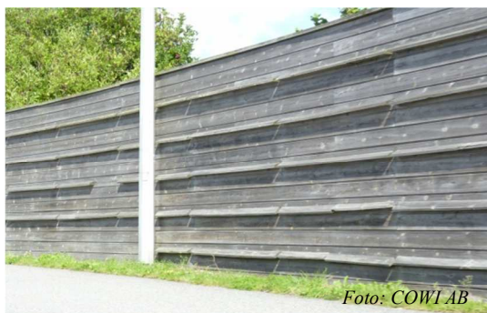
Figur 20 Exempel på bullerskyddsskärm i trä kring Grimmeredsmotet, Göteborg.
