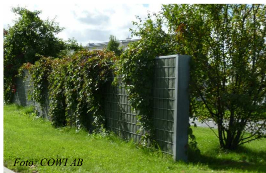
Figur 23 Exempel på absorberande bullerskyddsskärm från Hildedal, Göteborg.
