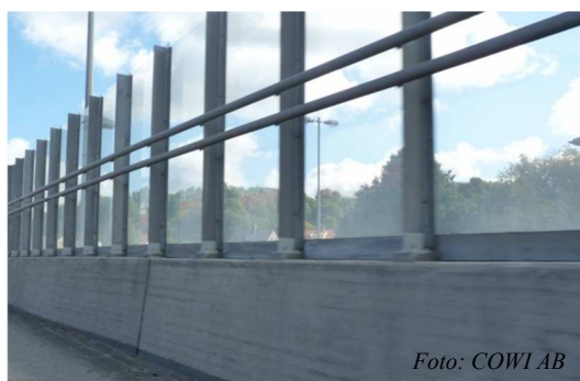
Figur 17 Exempel på bullerskyddsskärm i betong och glas från Ånäsmotet, Göteborg.
