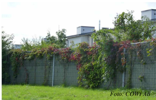
Figur 22 Exempel på absorberande bullerskyddsskärm från Hildedal, Göteborg.
