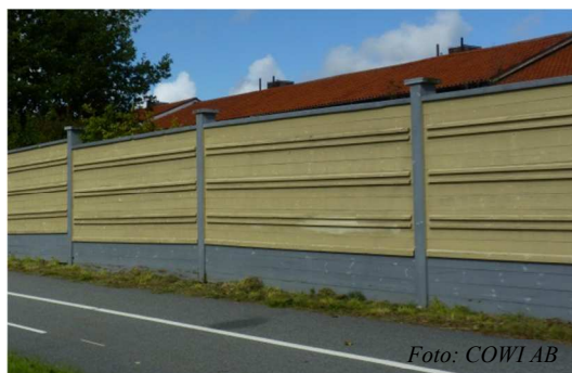
Figur 21 Exempel på bullerskyddsskärm i trä längs Björlandavägen, Göteborg.
