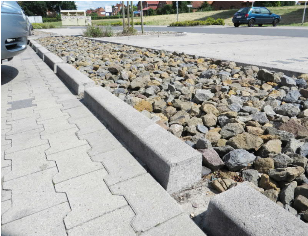
Figur 24. Krossdike vid parkeringsplats med utlopp från parkering till krossdike. Bildkälla: Svenskt vatten, 2008.
