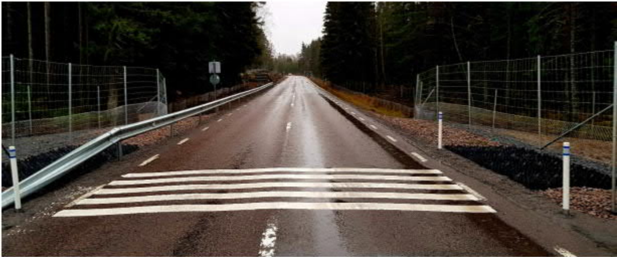
Figur 8. Linjer tvärs över vägbanan i syfte att leda djuren över vägen och även underlätta att fordonsförare ser djuren vid mörker eller dålig sikt. (Bild från Utredning av barriäreffekter för större däggdjur vid exploatering utmed Partillevägen förbi Öjersjö (Enviroplaning, Marcus Elfström, 2023)).
