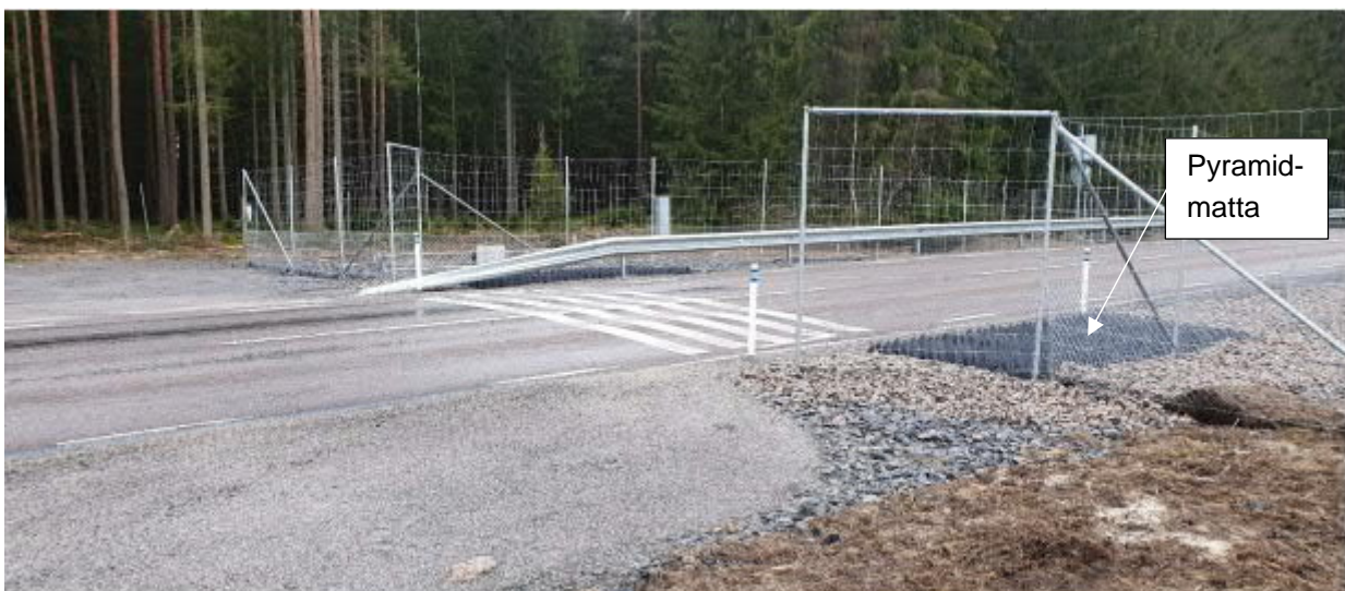
Figur 9. Bild inifrån detektionsyta i faunapassage i plan och ut mot vägbanan och stängslingen. (Bild från Utredning av barriäreffekter för större däggdjur vid exploatering utmed Partillevägen förbi Öjersjö (Enviroplaning, Marcus Elfström, 2023)).
