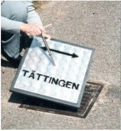
Figur 33. En s k Tätting, som placeras över dagvattenbrunnar.
