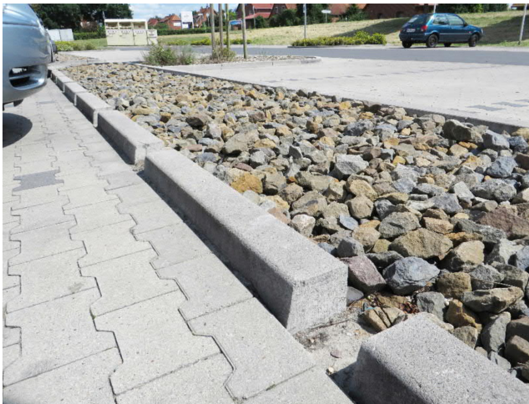
Figur 24. Krossdike vid parkeringsplats med s.k. "släpp i kantsten" till krossdike. Bildkälla: Svenskt vatten, 2008.
