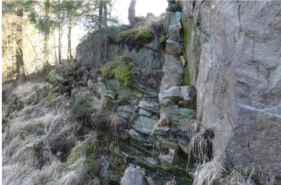
Figur 11 Bergsskärning vid väg 535 där man ser ett lokalt stråk med mer uppsprucket berg där även mindre mängd ytligt vatten påträffades.
