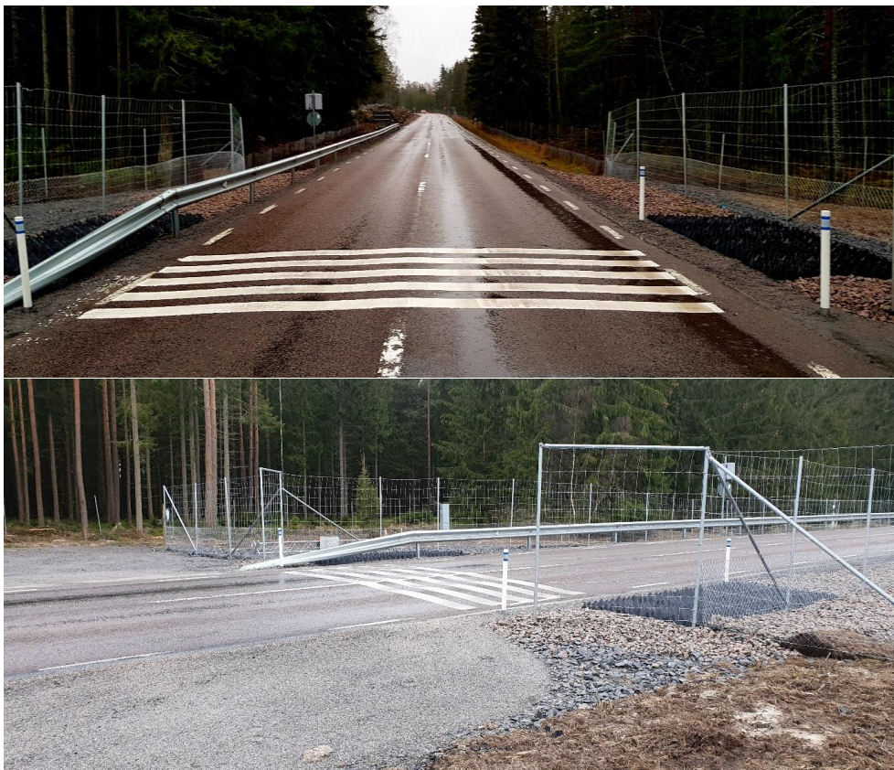
Figur 9. Vy utifrån trafikantens perspektiv utmed en planpassage för vilt. I bilden syns att viltstängslet inom 10 m från viltpassagen har dragits upp och är 1 – 1,5 m från vägbanans kant. Därutöver finns konmattor (pyramidmattor) anlagda och som fysiskt hindrar klövviltet från att beträda dikesremsan. Konmattorna förhindrar även uppkomst av örter och gräs från fröbanken. Tvärs över vägbanan har så kallade kontrastlinjer målats. De vita linjerna bortanför viltpassagen hjälper ankommande trafikanter att upptäcka korsande vilt mot en mörk vägbanan. Linjerna förväntas även bidra till att styra viltet rakt över vägbanan.
